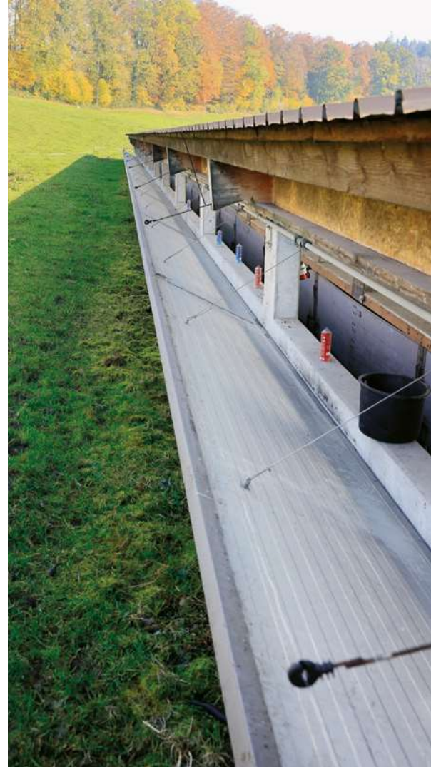
Die Rückwand lässt sich je nach Wetter über Winden öffnen und schliessen.
