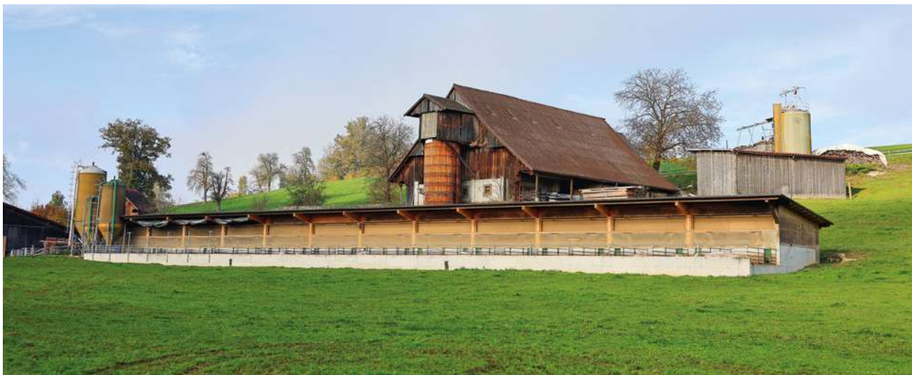
Die hohe, nach Süden gerichtete Front ist über einer Grundmauer mit einer sogenannten «Wendeklappe» ausgestattet. Sie lässt sich ganz öffnen.
